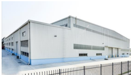
新鑄造工場外観
