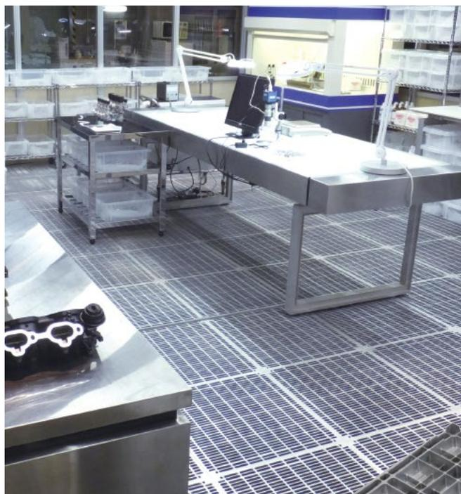
1962年、アーレスティは日本で最初のアルミニウムダイカスト製のフリーアクセスフロアパネル「モバフロア」を開発しました。フリーアクセスフロアとは、配線・配管を床下に納める二重床システムのことです。一般オフィスや病院などに幅広く利用されていますが、当社では特に半導体生産工場などのクリーンルームやデータセンター、コンピュータールーム用フロアパネルに注力しています。
