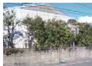
浜松工場の騒音対策（防音シート）
