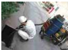
ポンプで流出汚水を吸引
