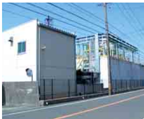
排水処理設備
