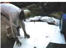
⑤ 吸着マットの設置 (流出部)
