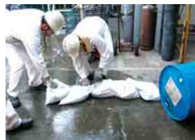
④ 土のうの設置 (流出部)
