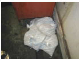
⑤ 排水ピットを土嚢で塞ぐ
