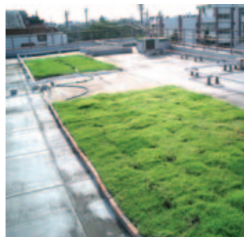
本社の建物は3階建てで、従来、屋上はコンクリート平面(約660m 2 )のみで何もなく、都会のヒートアイランド現象を助長していましたが、2002年から屋上に芝生などの植栽を施し、環境保全に貢献しています
