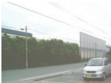
近隣への騒音対策として敷地境界に防音壁を設置
