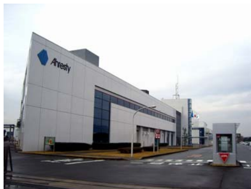
本社・テクニカルセンター外観
