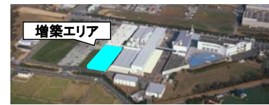
アーレスティプリテック豊橋工場増築 工事箇所
