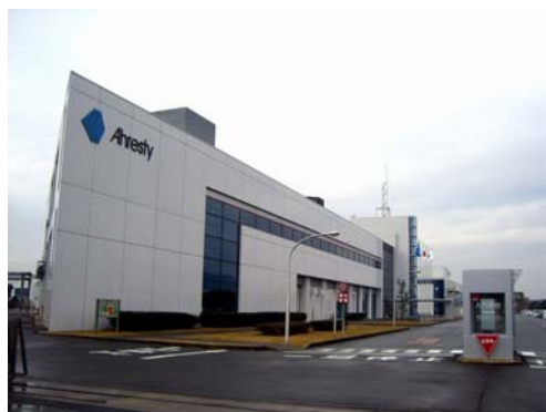
本社・テクニカルセンター外観
