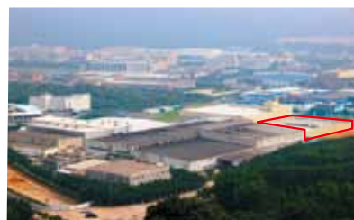
広州アーレスティ第1工場、新工場の全景と拡張工事箇所 (6月現在)
