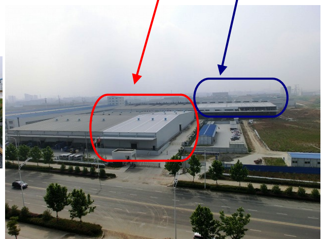
第3期工事箇所
