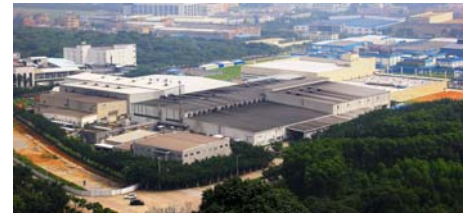
第1工場、新工場の全景(2013年5月時点)
