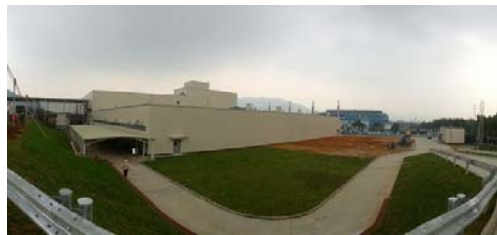
新工場の第1期工事竣工後の外観 (2013年5月時点)
