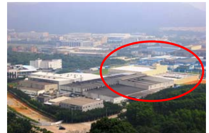
広州アーレスティ第1工場、 新工場の全景と拡張工事箇所
