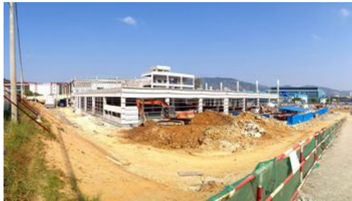
新工場工事の様子(2013年1月時点)
