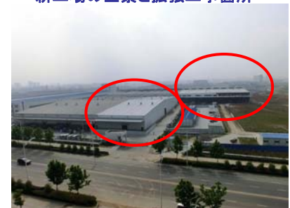
合肥アーレスティ拡張工事箇所
