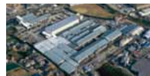
東海工場(豊橋) 〒441-3153 愛知県豊橋市二川町字東向山80 TEL.0532-41-0511
