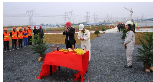
地鎮祭の様子(2012年10月)
