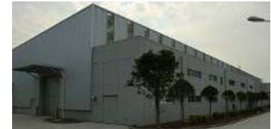
ダイモールド広州第2期工事完了
